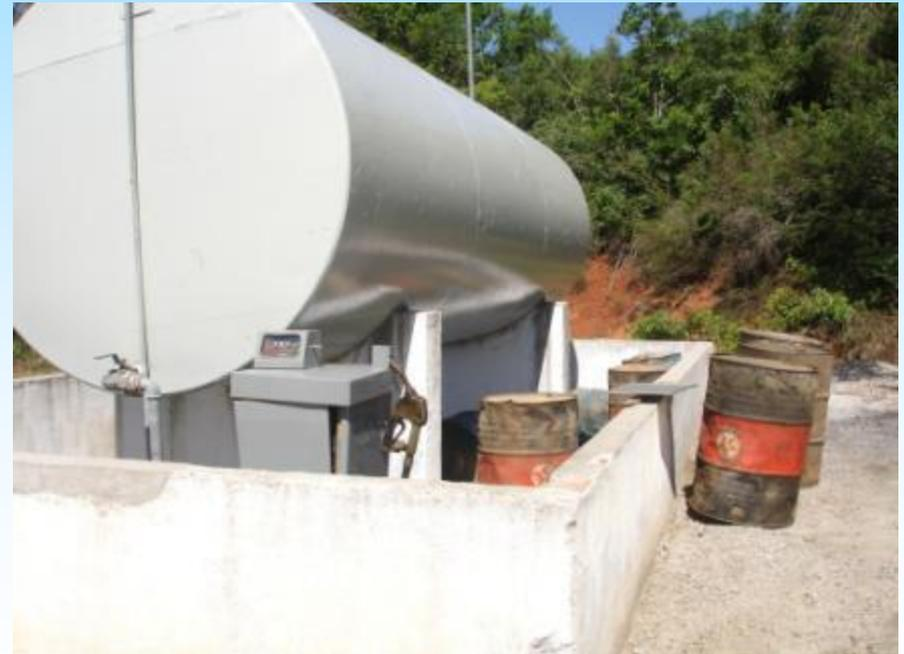
**Medida ambiental: sistemas de estocagem de combustíveis e lubrificantes com muretas de contenção e caixas separadoras óleo - água**
