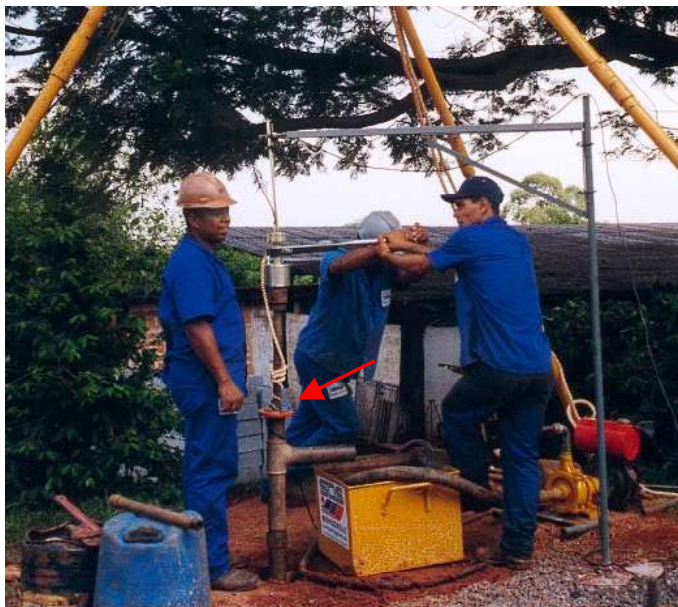
FIGURA 23 - Disco-centralizador utilizado no sistema de lavagem
