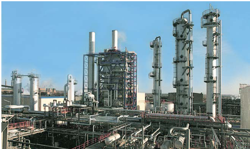
Figura 3: Planta de metanol com capacidade de 140 mil t/d localizada em Schwarze Pumpe na Alemanha.
