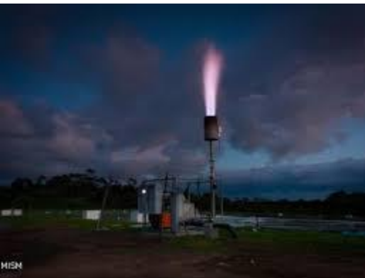
Queima do Biogás
