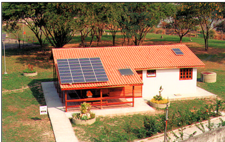
Casa autosuficiente em energia, dotada de painel fotovoltaico de 2kWp e banco de baterias de 28kWp
