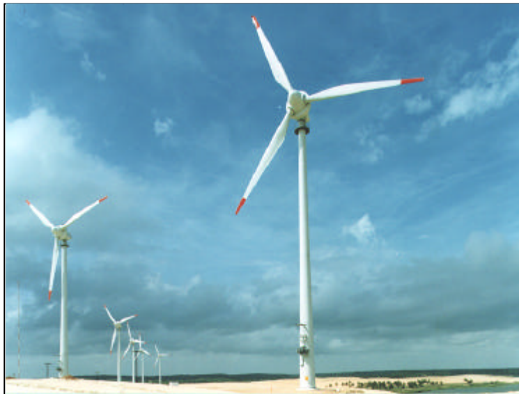
Fazenda Eólica de Taíba, CE, com potência de 5 MW (10 turbinas eólicas de 500kW)
