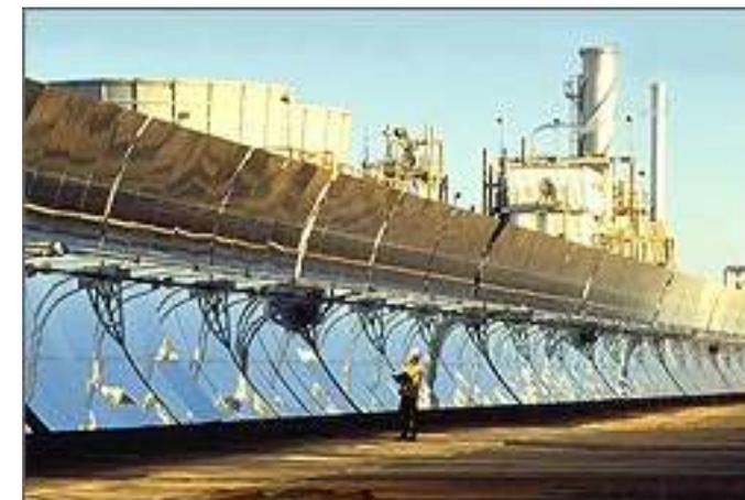
Figura 5.7 - Aspecto de uma calha parabólica de uma central termo solar
