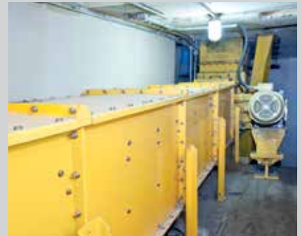
TCRA PARA DESCARGA DE MOEGA
