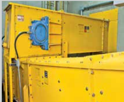
TCRA PARA DESCARGA DE MOEGA
