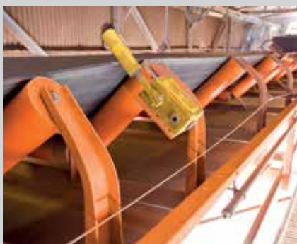
CORREIA TRANSPORTADORA 1.500 t/h (54")
